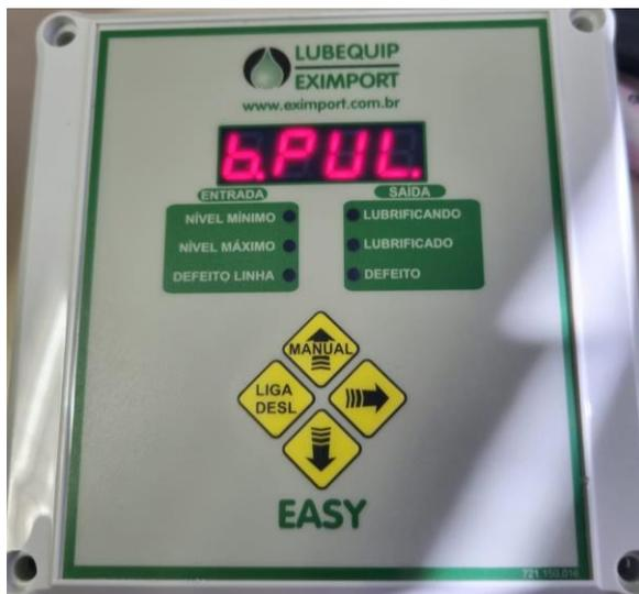
b.Pul (Bomba Pulsada) significa que a bomba trabalhará de modo alternado. Funcionando por 2 segundos e desligando por 2 segundo. Essa configuração é utilizada para sistemas de linha simples. Pressionando o botão “seta para cima ou para baixo” muda essa configuração. Para ir ao próximo, pressione “seta para a direita”
