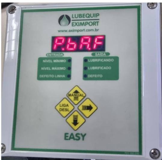
PbAF (Pressostato de Baixa com contato NF).
