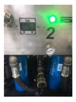
d) Ao final da transferência desligue a bomba, desconecte a mangueira.
